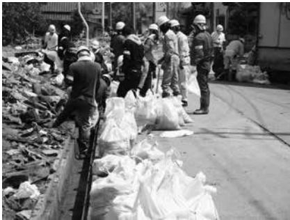
ボランティアによる側溝の泥上げ作業。
